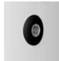
Гнездо установки температурного датчика котла
